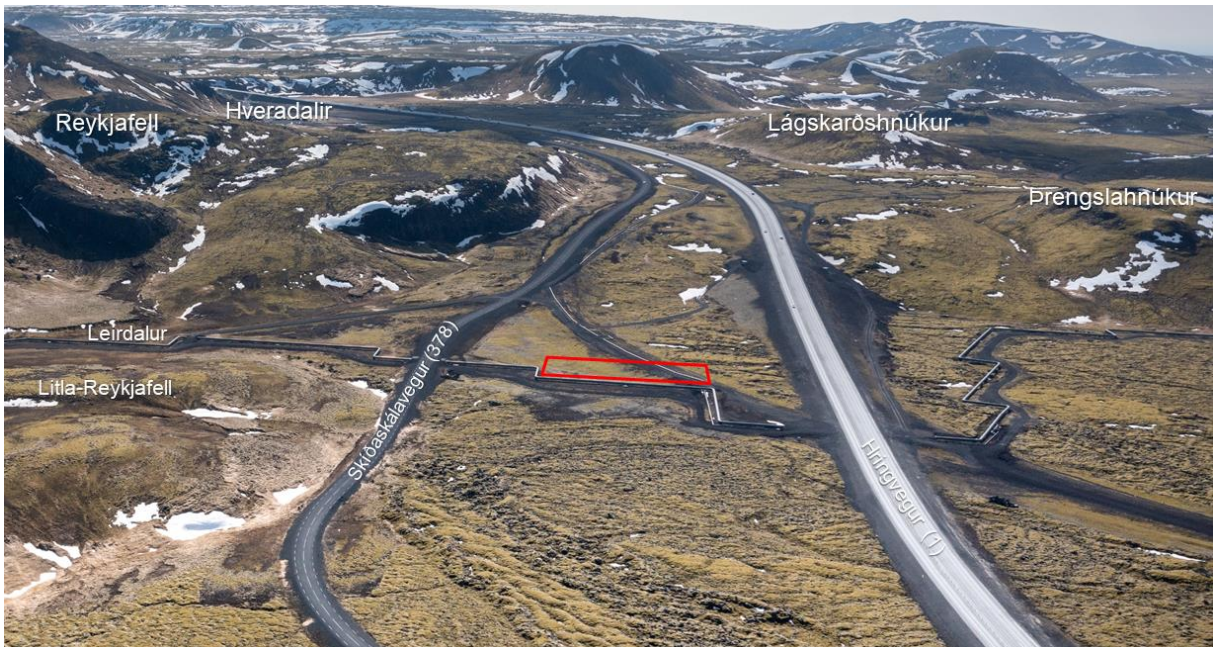
Mynd 4.2 Svæði fyrir nýja dælustöð austan við núverandi niðurrennslistögn og norðan við Hringveg (1). Gróf afmörkun reits fyrir dælustöð og tengingu lagna er sýnd með rauðum línunum.
